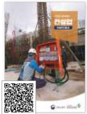
건설업-가설 전기 공사
